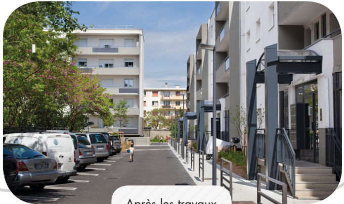
Après les travaux
