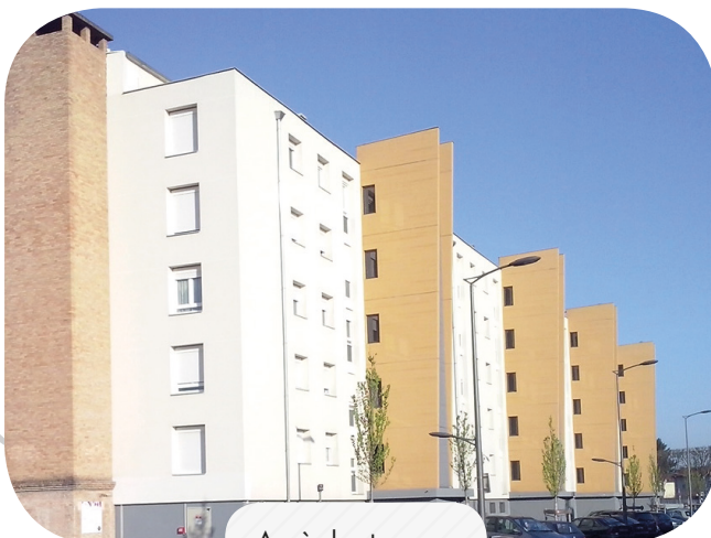
Après les travaux
